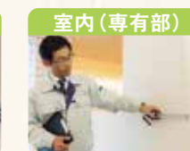
室内の床の傾斜
