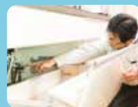
給排水管路検査
