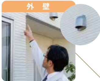
外壁 外壁のひび割れ、欠損、はがれ、サッシの周囲の隙間、開閉不良はないか
