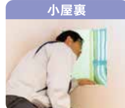
小屋裏 小屋裏の劣化状況の確認
